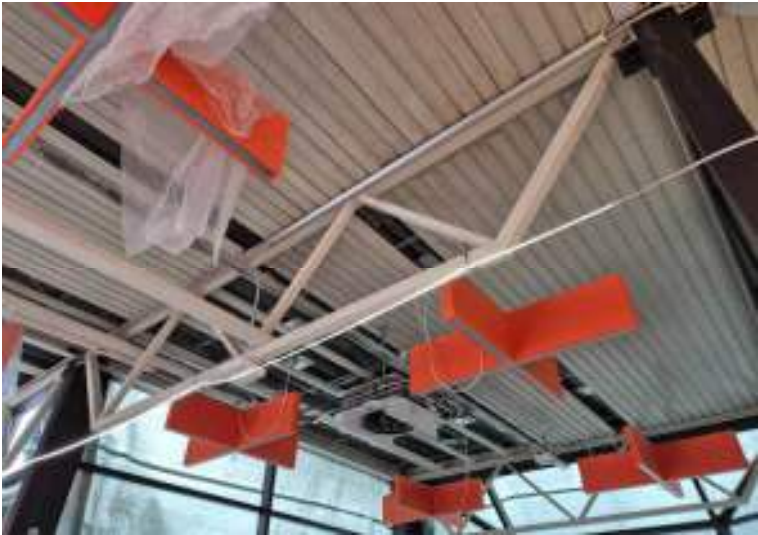
Itäkeskuksen metroasema: inventoituja rakennusosia
