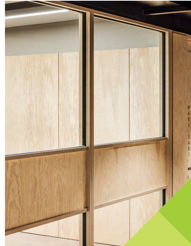
Kaikukadulla toteutettiin kokeilu, jossa käytöstä poistettuja ikkunoita käytettiin sisätiloissa väliseiniä. Kuva: Martin Sommerschield
